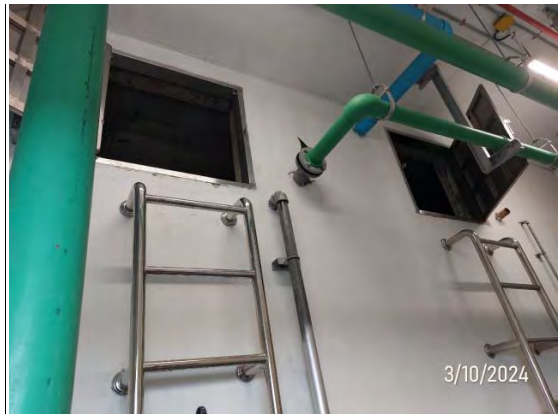
รูปที่ 2-18 ถังสำรองน้ำชั้นใต้ดินแบบ 2 ฝาถัง
