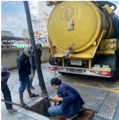
รูปที่ 2-20 การสูบล้างปลักและกากไขมัน
