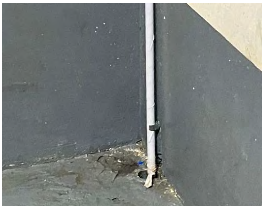
รูปที่ 2-31 ท่อรวบรวมน้ำเสียในห้องพักรวม
