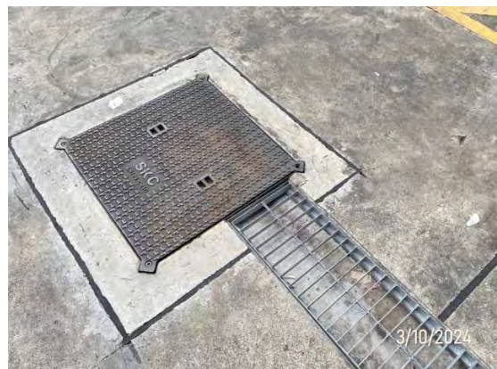
รูปที่ 2-32 รางระบายน้ำจากห้องพักรวม
