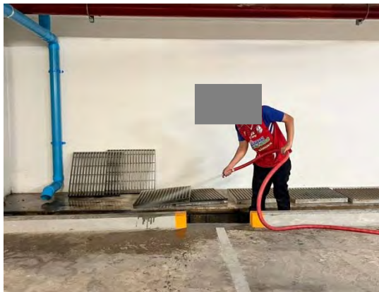
รูปที่ 2-25 การทำความสะอาดรางระบายน้ำ
