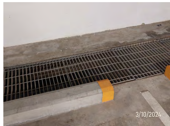
รูปที่ 2-61 ตะแกรงครอบท่อระบายน้ำ
