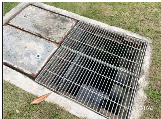
รูปที่ 2-22 ตะแกรงดักขยะด้านหน้าโครงการ
