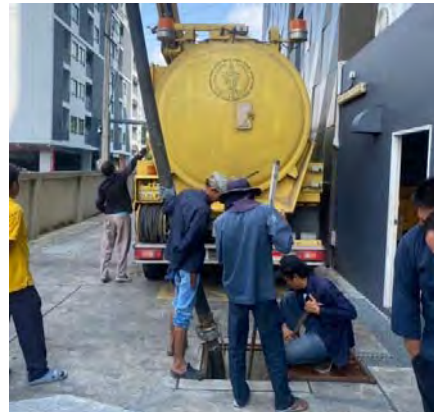
รูปที่ 2-20 การสูบล้างปลักและกากไขมัน
