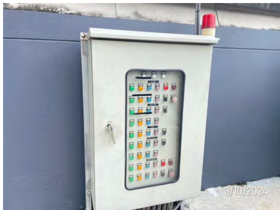
รูปที่ 2-21 ตู้ CONTROL ระบบบำบัดน้ำเสีย
